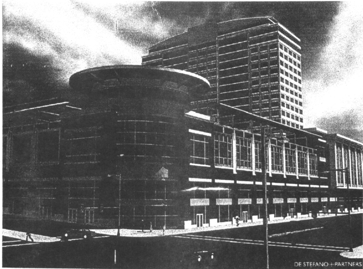
3- Central Station, Chicago, Illinois. De Stefano + Partners. Vista desde la esquina. Formato jpg, 321KB, resolución 1024x768.
