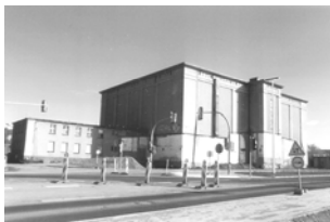
Abb.VIII-27 Kühlhaus Gera – Nordwest-Ansicht
