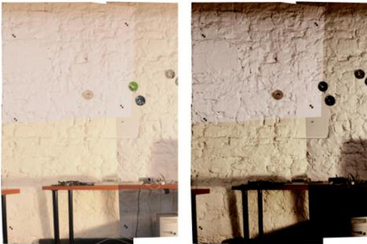
Abb. 21: Digitale Nachbearbeitung von entzerrten Fotos. Die unverputzte Wand wurde weiß gefüncht. Dadurch ist die Mauerwerksstruktur nur sehr schlecht zu erkennen (linkes Bild). Im rechten Bild wurden Kontrast, Helligkeit und Farbwerte so verändert, daß sich die Steinstruktur wesentlich einfacher erschließen läßt. Voraussetzung ist natürlich die richtige Ausleuchtung bei der Aufnahme der Meßbilder.
