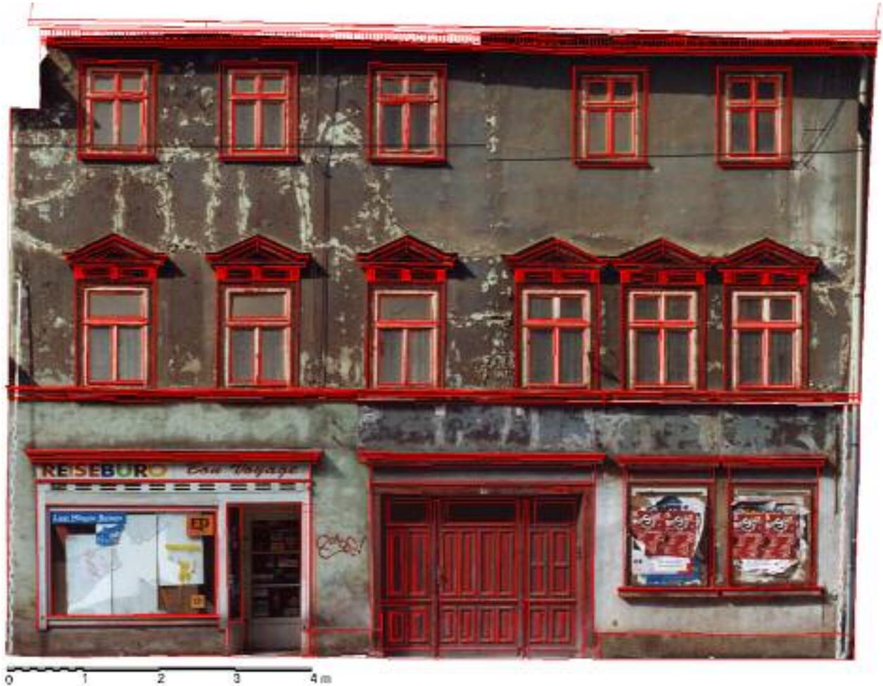
Abb. 31: Verbindung von tachymetrisch aufgenommenen Informationen mit entzerrten Fotos. Das tachymetrische Aufmaß wird durch die entzerrten Bilder in sinnvoller Weise ergänzt. Zusätzlich zu den geometrischen Formen wurde so der Zustand der Fassade dokumentiert. An den Fotos läßt sich auch erkennen, das sich hinter dem Putz eine Fachwerkkonstruktion verbirgt.
