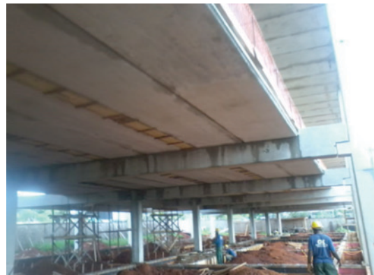
Figura 3: Andamento da obra
